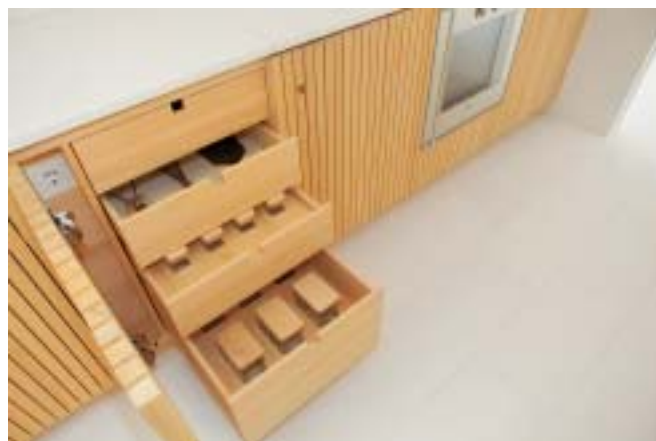
Die Einteilung der Schubkästen überlässt nichts dem Zufall. Zurückgesetzte Blende mit Steckdose im Bandbereich
