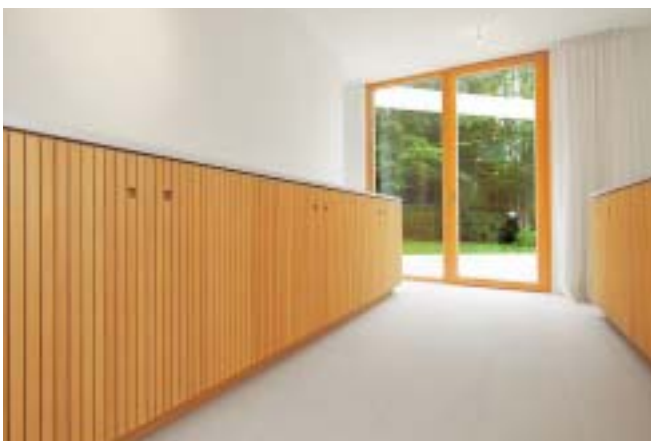
Auch die Fronten der Küche lösen sich in vertikale Leisten auf: Rücksitig eingefräste Gratleisten stabilisieren das Raster
