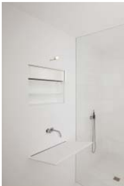
Der Spiegel verfährt mit einem Hublift hinter die Trockenbauwand und gibt ein Regal frei
