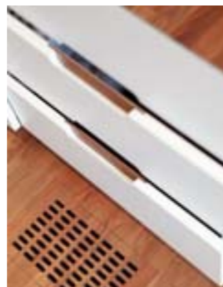
Details von der Rückseite der Bettwandscheibe: Schubkasten-Griffnut und gefräste Lüftungsschlitze im Nussbaumparkett
